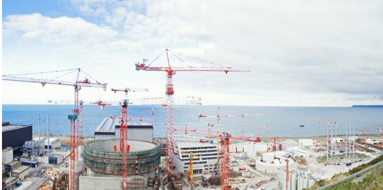
Cantiere di Flamanville3, Normandia
